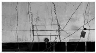
(b) 커플러 연결부 균열 10.46
