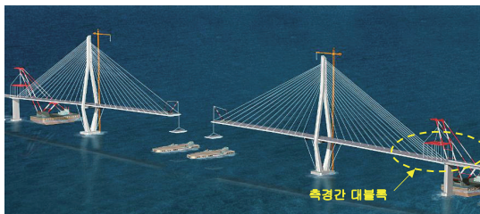
STEP 3 : 축경간 대볼록 시공(해상크레인)
