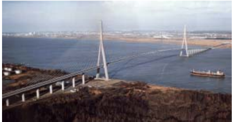
Figure 8 Pont de Normandie
