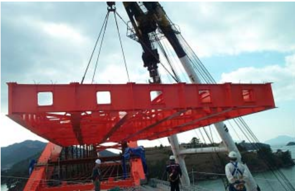
(Side Span Steel Girder 가 )
