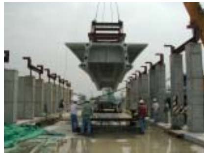
그림 19. 제작 Segment의 이동
