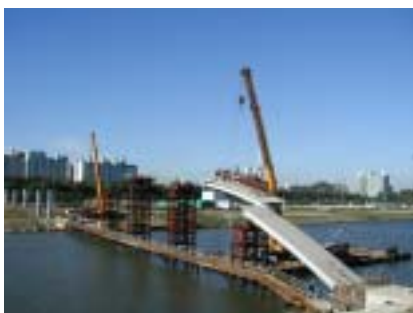
그림 20. Segment Erection
