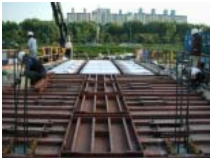
그림 18. 상부거푸집 설치
